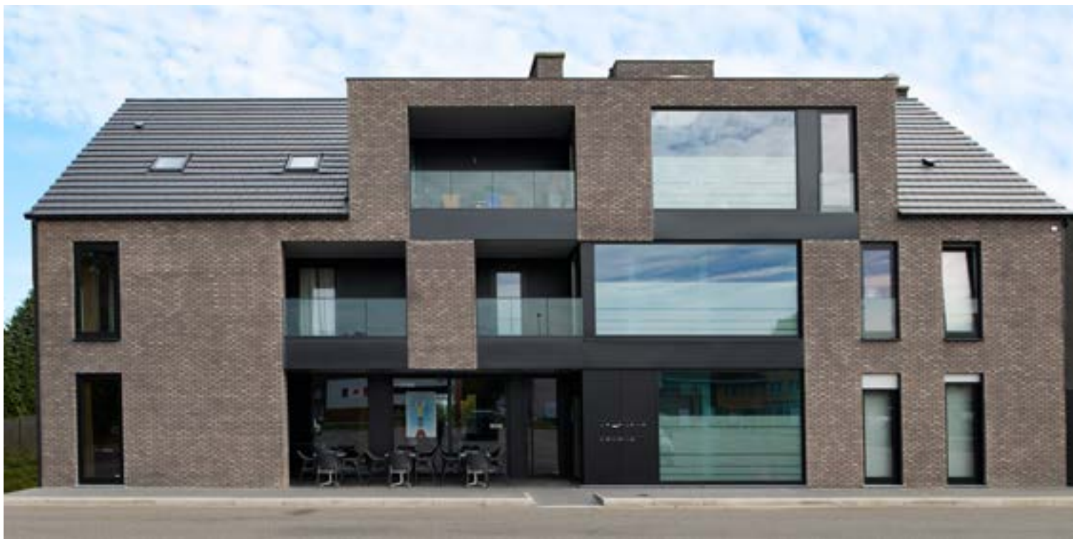
E.Meertens Architecten,, г. Римст
